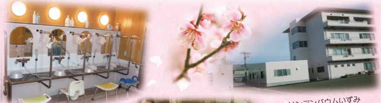
リンデンバウムいずみ デイサービスセンター 新浴室棟外観
